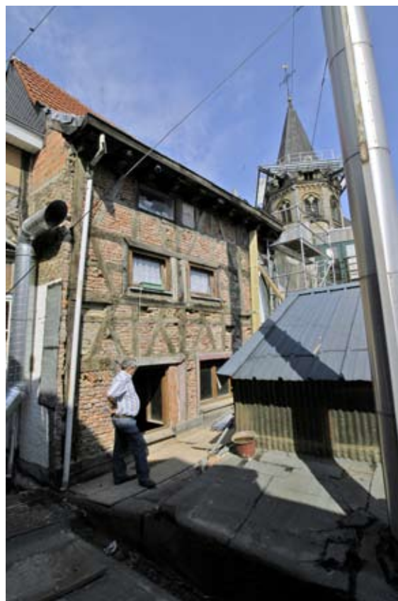
« Maison de la Pomelette d'Or ». Vue partielle de la façade arrière © SPW
