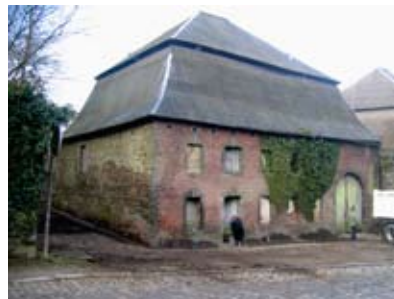
Vue générale de la grange
