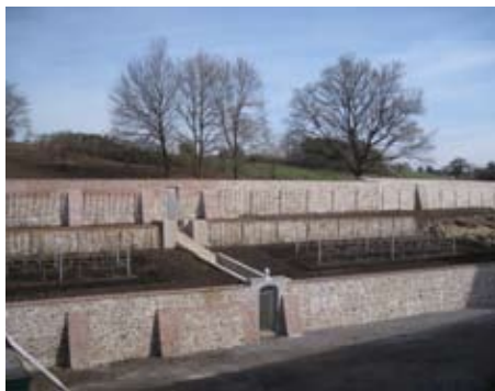
Aménagement des abords nord du site
