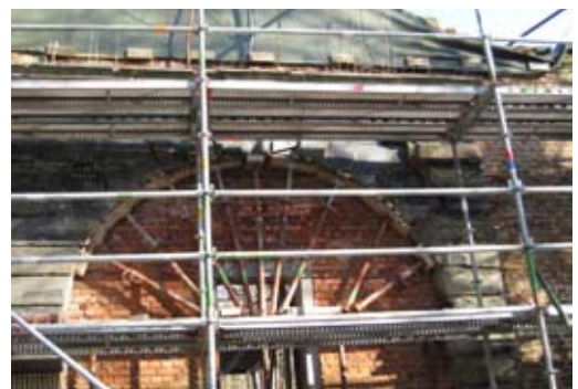
La porte de la ferme en chantier, architecte Marie Taminiaux (IPW)
