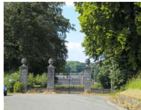
Portail sud : grille d'entrée Photo F. Desmet © F. Desmet
